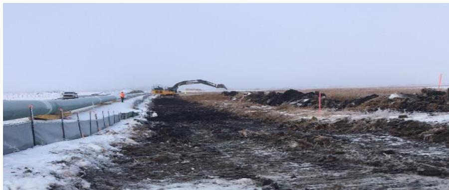
731 + 575 Wetland SK 805 Track hoe stripping upper layer
